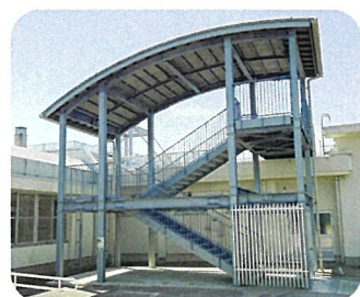
津波避難用屋外階段
